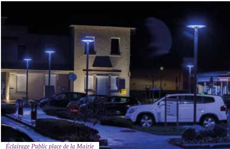
Éclairage Public place de la Mairie
