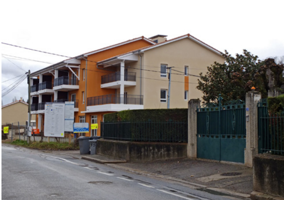
Logements collectifs en construction sur la Grande Rue
